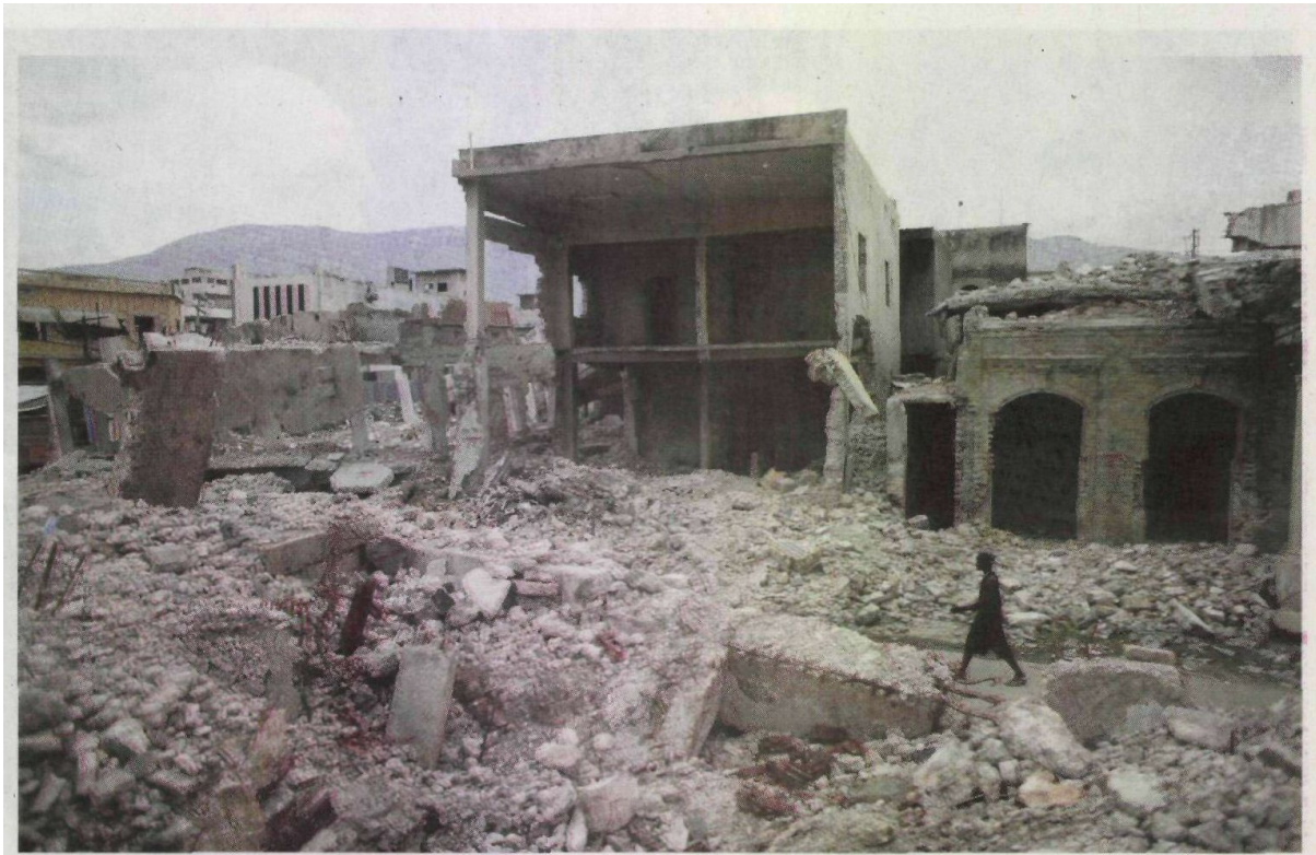
Partout, à Port-au-Prince, ce ne sont encore qu'amas de décombres et édifices effondrés. Ici, fin juin. ALEXANDRE MENEGHENI/AP
