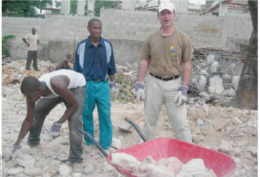
Le P. Hubert Hirrien et son équipe sur le chantier de reconstruction du local de la pastorale universitaire.
